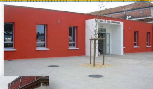
Mairie de quartier nord : création d'un pôle administratif et aménagement des extérieurs
