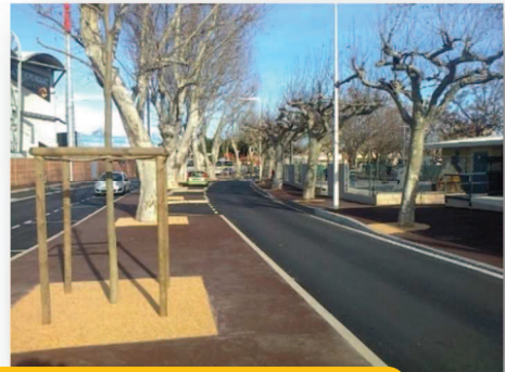
Rue du Méridien : requalification globale de la rue (voirie, trottoirs, stationnement...)
